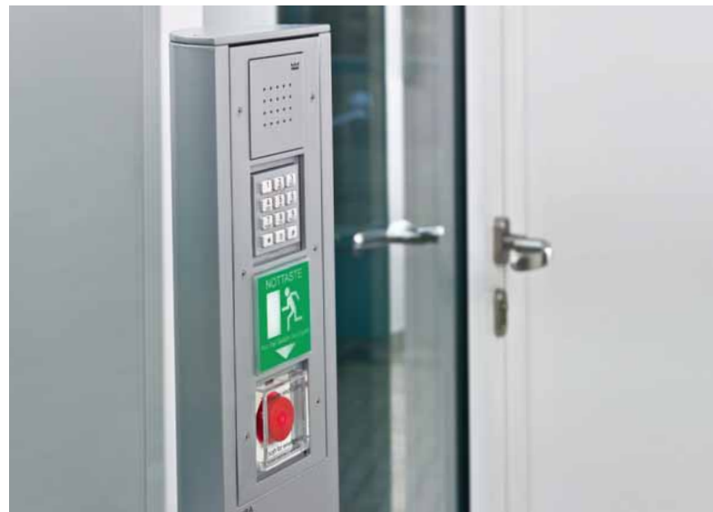
TMS Fluchtwegsicherung
